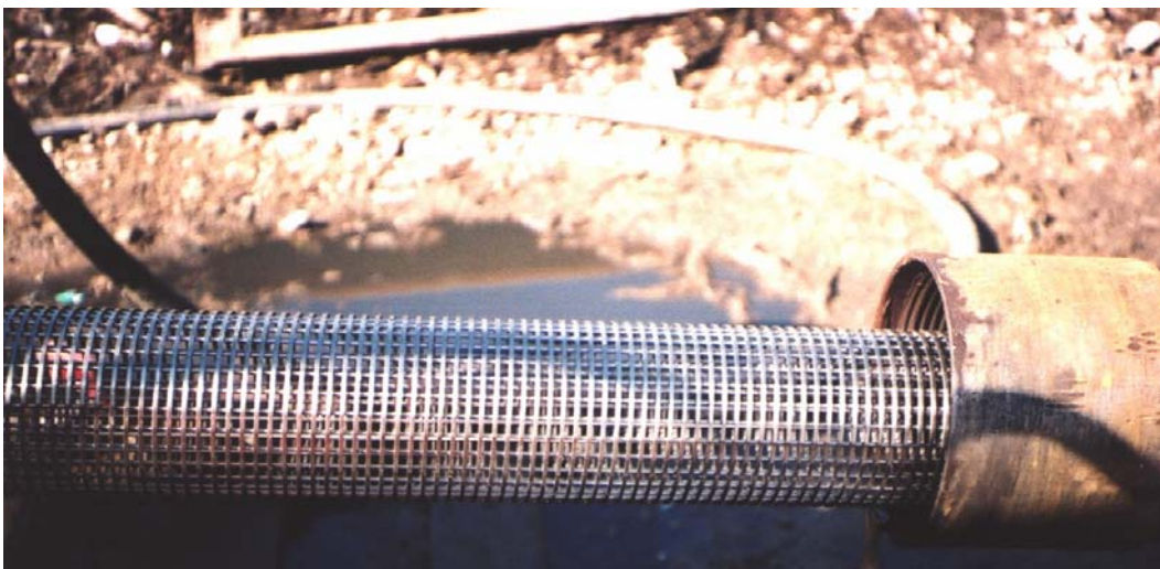
Abb.3: Wickeldrahtfilter aus Edelstahl beim Einbringen in das Schutzrohr
