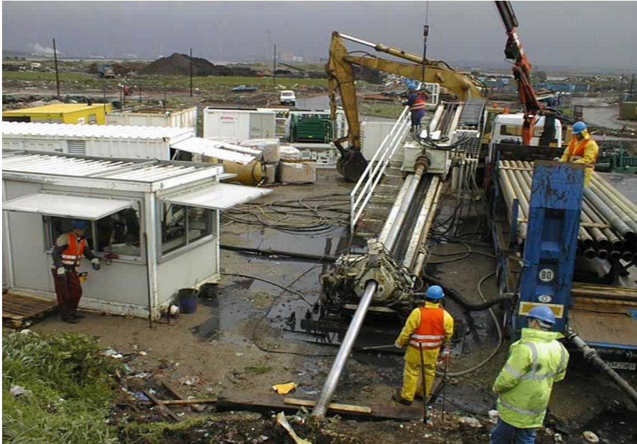
Abb.2: Die 100 Tonnen Bohranlage beim Einsatz in Rainham
